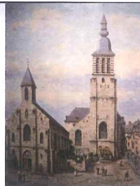
Frans Kegejan [1847-1921] L'église Saint-Jean-Baptiste et l'ancienne église Saint-Loup en 1619. Huile sur panneau, 1916. La première église Saint-Loup est citée dès le dernier quart du 12 e siècle et dépend de l'église de Liège. Namur, Ville de Namur 1918.1.104
